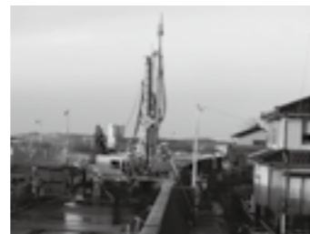
民家に近接しての施工 ▶ P.53
