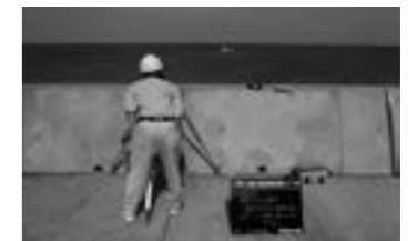
人工リーフの高さを確認している様子 ▶ P.61
